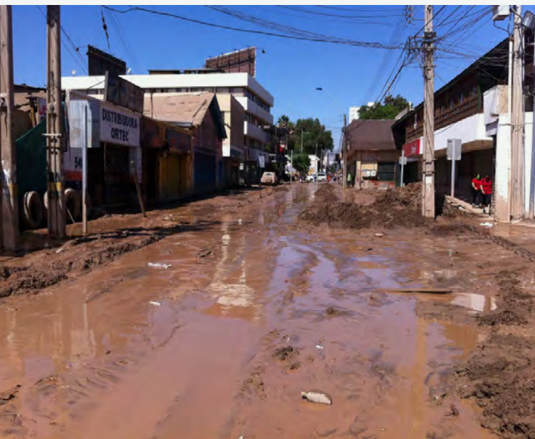
Gemäss Berichten wurden 105 Häuser von der Flut komplett zerstört; weitere 5900 Häuser wurden schwer beschädigt.
